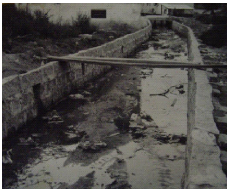
Figura3: Trecho da obra de canalização Rio Criciúma na década de 1950.
