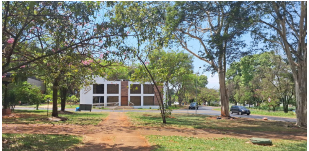
Figura 4 – Lote RUV do CLS 214 vazio e ao fundo o RUV do CLS 213 construído
