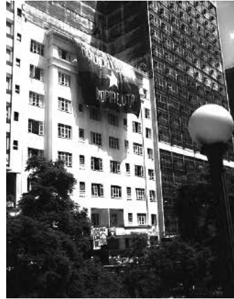
Figura 2: Fachada do prédio atualmente
