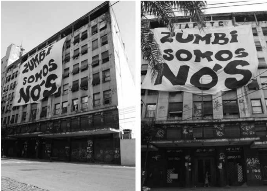
Fachada da ocupação Zumbi dos Palmares.
