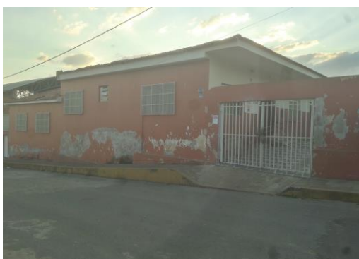
Figura 3 - Escola Municipal Arlindo de Mello Fonte: Autores (2019).
