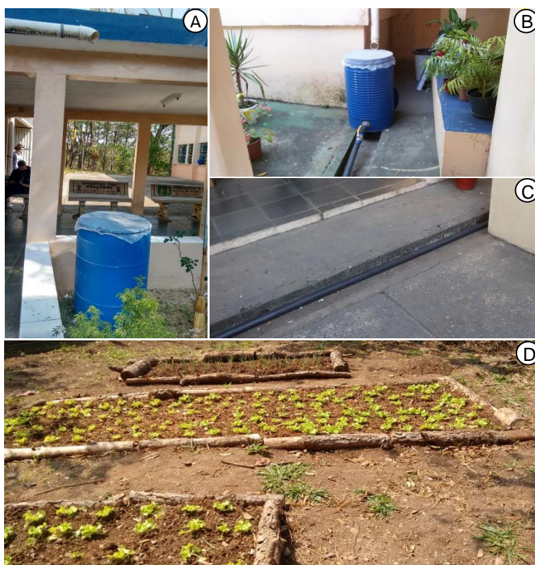
Figura 1. Preparo e instalação dos materiais recicláveis referentes ao sistema de captação de águas pluviais no pátio da Escola Estadual Ivens Vieira (Angatuba/SP). A, B. pontos de captação de água pluvial; C. mangueira para transferência da água, recolhida nos tambores, para os pontos de irrigação; D. área de cultivo de hortaliças (horta) que recebe a água coletadas as chuvas. Crédito das imagens: C. G. Momberg da Silva.
