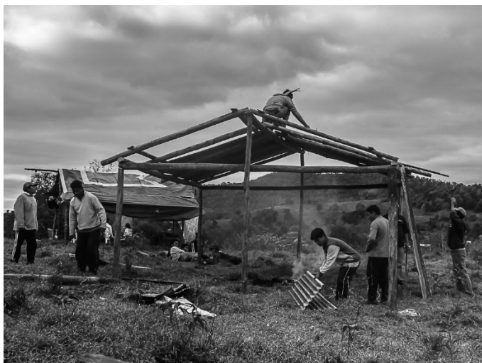
Construção de uma casa na nova retomada. TI Kanhgág ag Goj, julho de 2016. Fotografia da autora.
