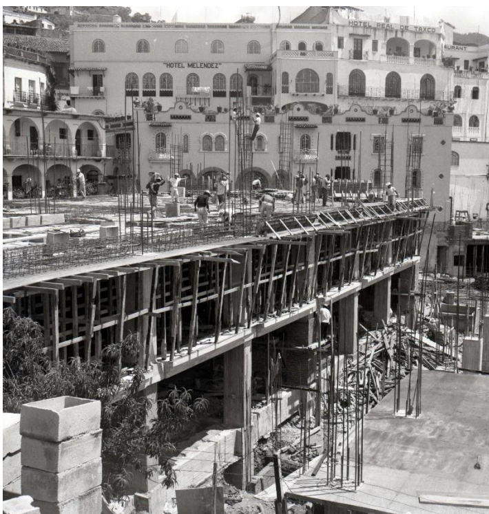
Figura 3: (FJC-MER-1969-0785-014) Construcción del nuevo mercado de Tetitlán, junio de 1969. Fotografía de Juan Crisóstomo Estrada
